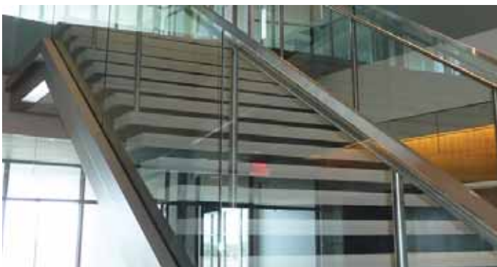
Distant mounting according to marble distance Bei Marmorüberhang, Montage mit Abstand Montage intermittente selon les parties saillantes de marbre
